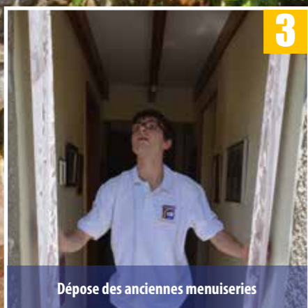
Vérification de conformité des mesures avant dépose des anciennes menuiseries
